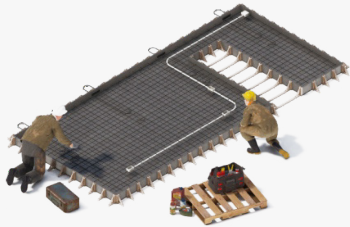
1. ENCOFRADO, ARMADURA E INSTALACIONES
