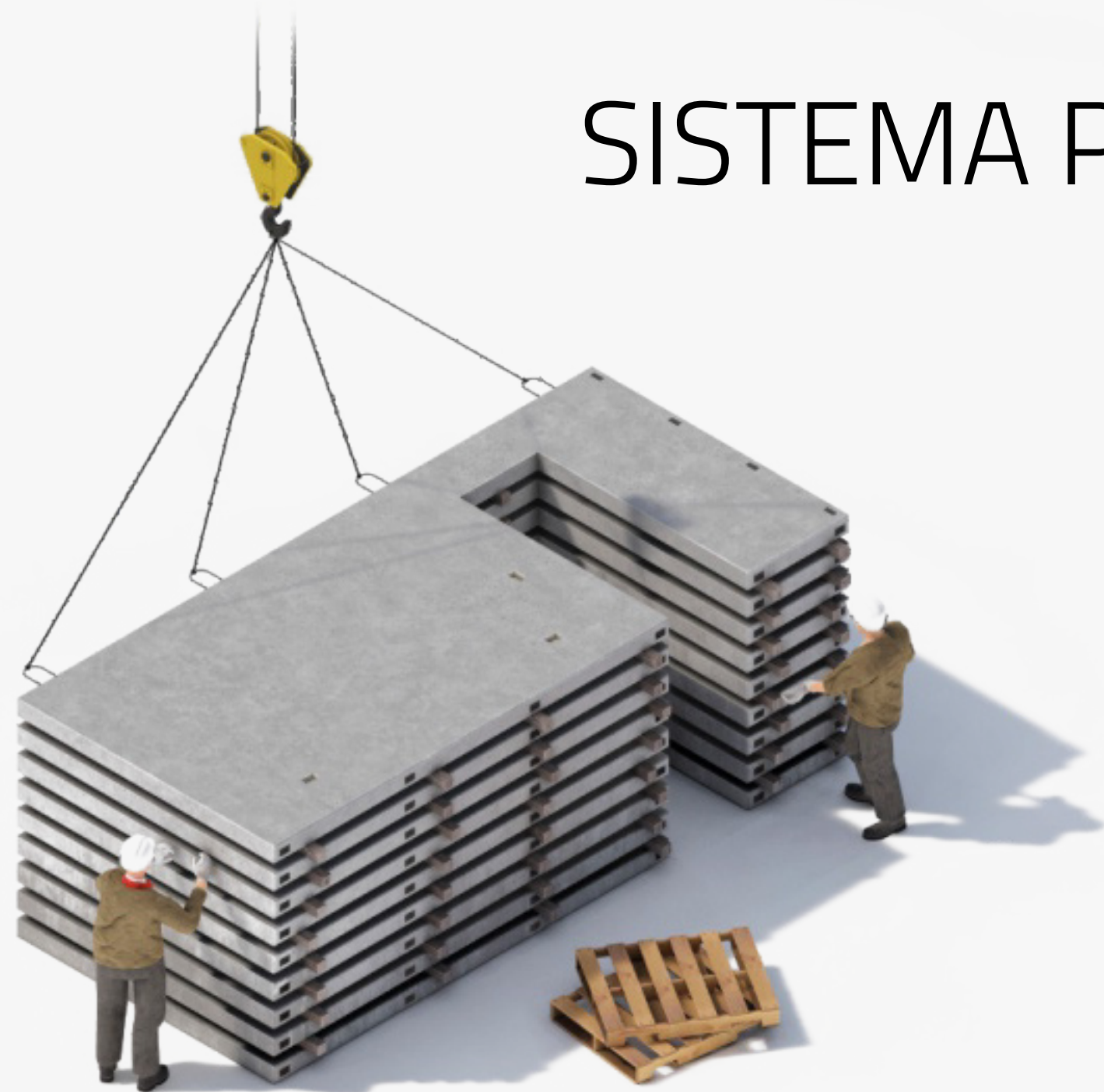
4. ACOPIO DE PANELES
