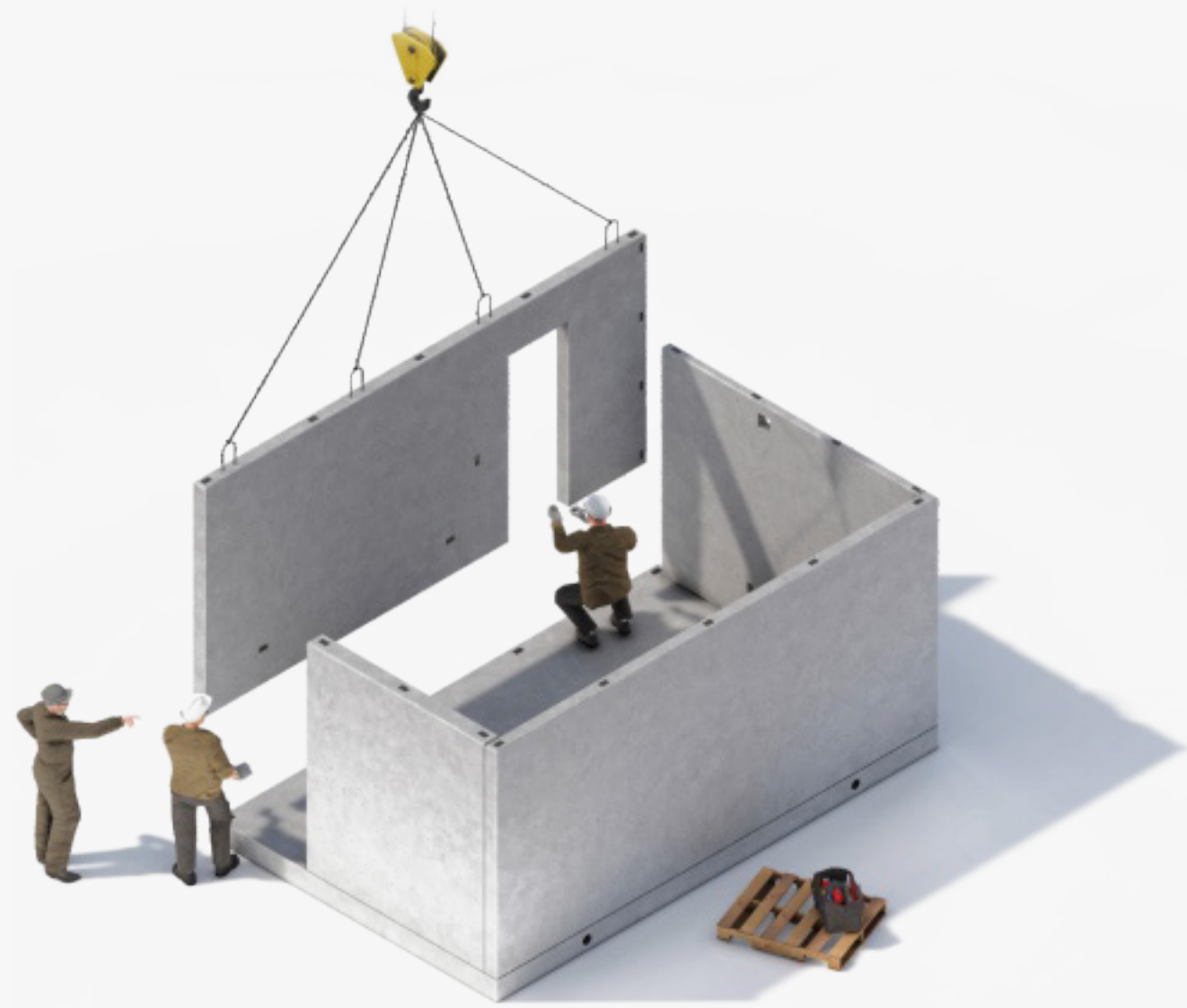
1. MONTAJE DE LOSAS Y PANELES
