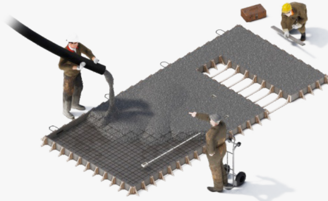
2. COLADO DEL HORMIGÓN
