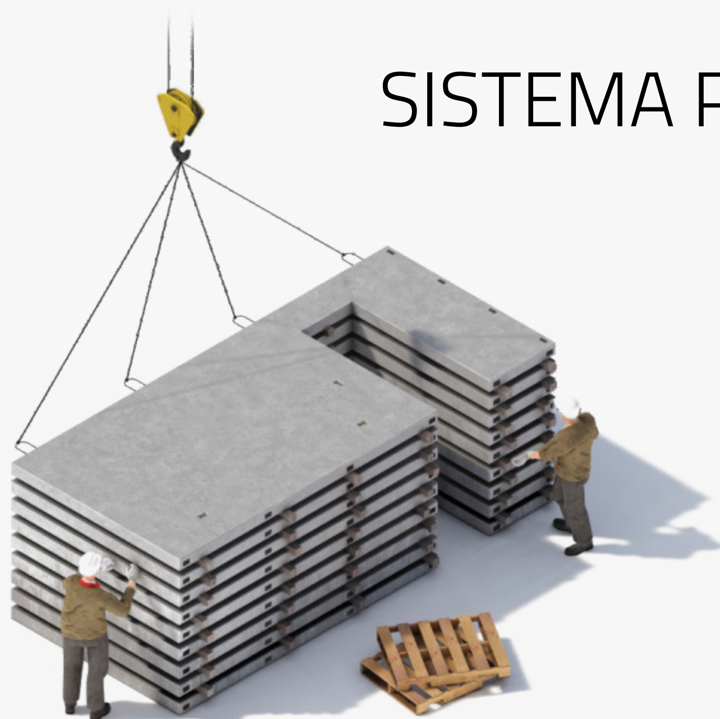
4. ACOPIO DE PANELES
